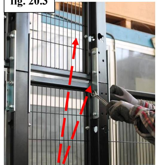
3) stringere le viti del montante e del telaio
