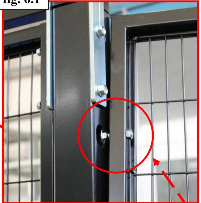
Nel telaio le viti con la testa tonda sono già pre-montate
