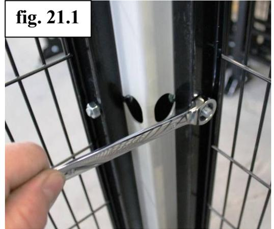
1) Svitare completamente tutti e 6 i dadi del telaio avvitati alla vite testa tonda, lasciando cadere la vite dentro il palo e rimuoverla da sotto (**attenzione, il telaio non è più sorretto**)
